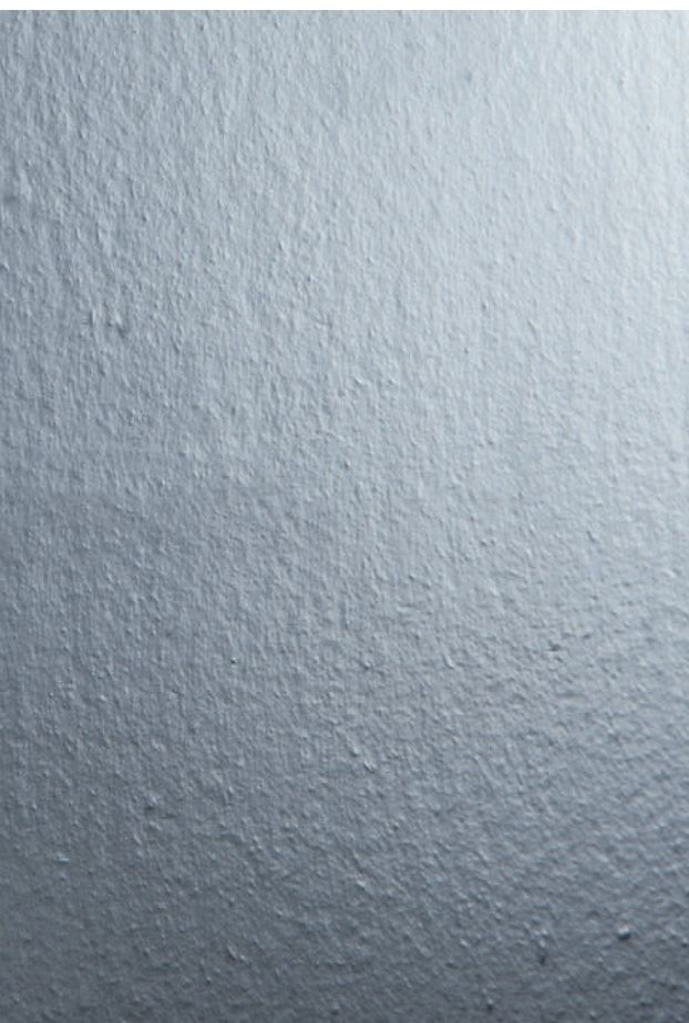
Barrière de vapeur revers de la dalle
